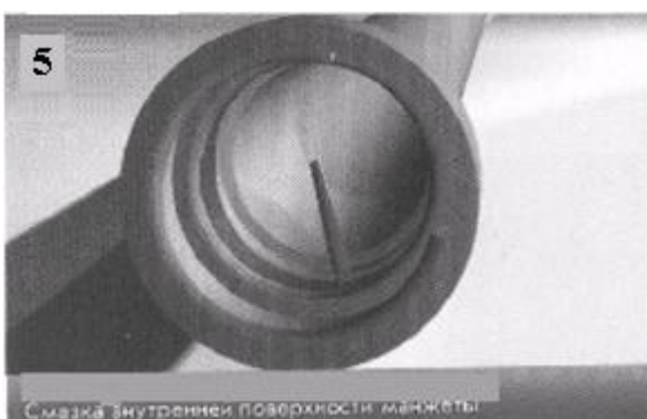
Смазка внутренней поверхности уплотнительного резинового кольца
